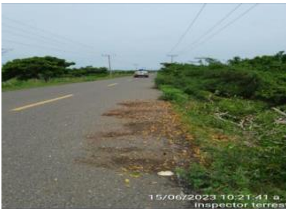
Fotografía 13. Retiro árbol caído sobre la calzada. Abscisa: 19 +480 Santa Lucía – Villa Rosa.
