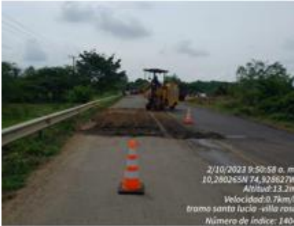
Fotografía 18. Reparación de Pavimentos
