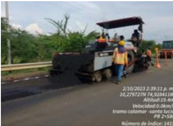
Fotografía 19. Reparación de Pavimentos Tramo Calamar – Santa Lucía.
