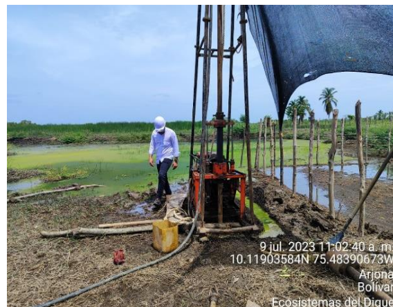
Fotografía 48. Perforaciones por parte de contratista Geotecnia y túneles.
