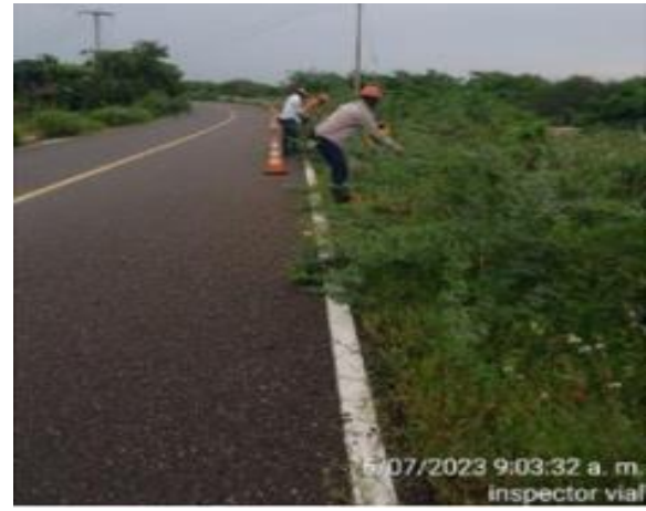
Fotografía 11. Actividades de mantenimiento rutinario Diques UF0. Tramo Calamar – Santa Lucia
