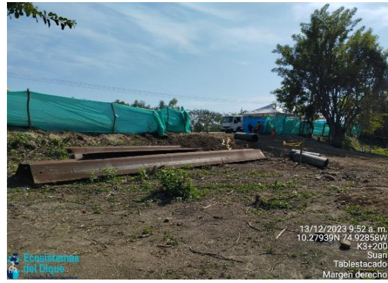
Fotografía 57. Acompañamiento, Instalación y adecuación de equipos
