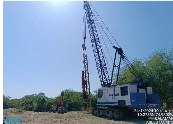
Fotografía 58. Acompañamiento durante actividades de tablestacado, Municipio de Calamar.
