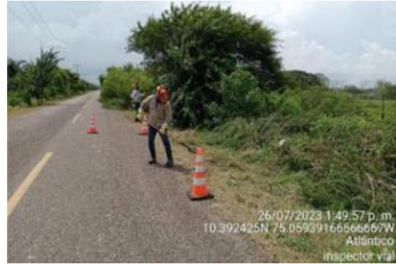
Fotografía 15. Rocería en márgenes de vías – Diques UF0 Tramo Santa Lucía – Villa Rosa
