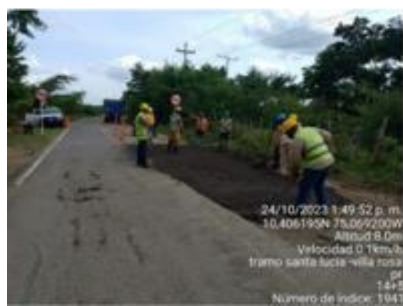
Fotografía 23. Reparcheo en vías UF0. Tramo Santa Lucía – Villa Rosa.
