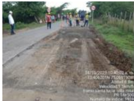
Fotografía 22. Reparcheo en vías UF0. Tramo Santa Lucía – Villa Rosa.
