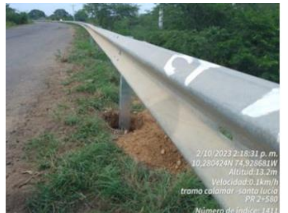
Fotografía 16. Instalación de parales y capta faros en defensas metálicas Tramo Calamar – Santa Lucía UF0
