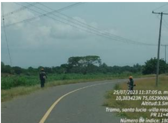
Fotografía 14. Rocería en márgenes de vías – Diques UF0 Tramo Santa Lucía – Villa Rosa
