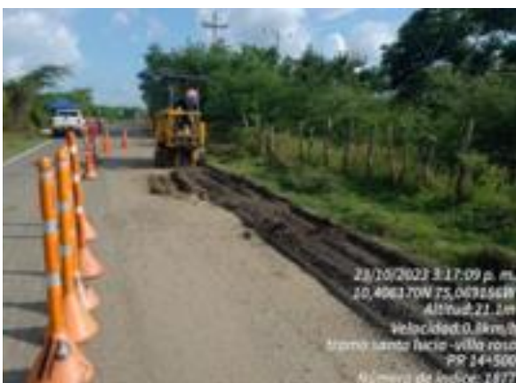
Fotografía 20. Trabajos de fresado abscisado vías UF0. Tramo Santa Lucía – Villa Rosa.
