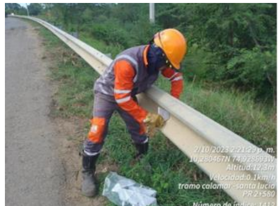
Fotografía 17. Instalación de parales y capta faros en defensas metálicas Tramo Calamar – Santa Lucía UF0
