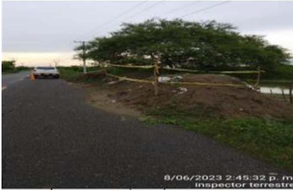
Fotografía 12. Señalización acopio de materiales - MI
