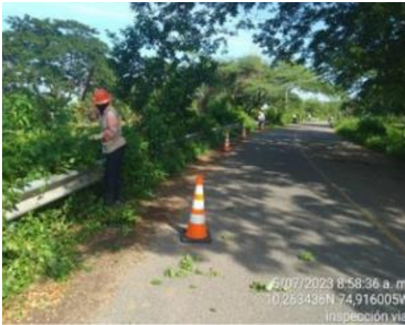
Fotografía 10. Actividades de mantenimiento rutinario Diques UF0. Tramo Calamar – Santa Lucia
