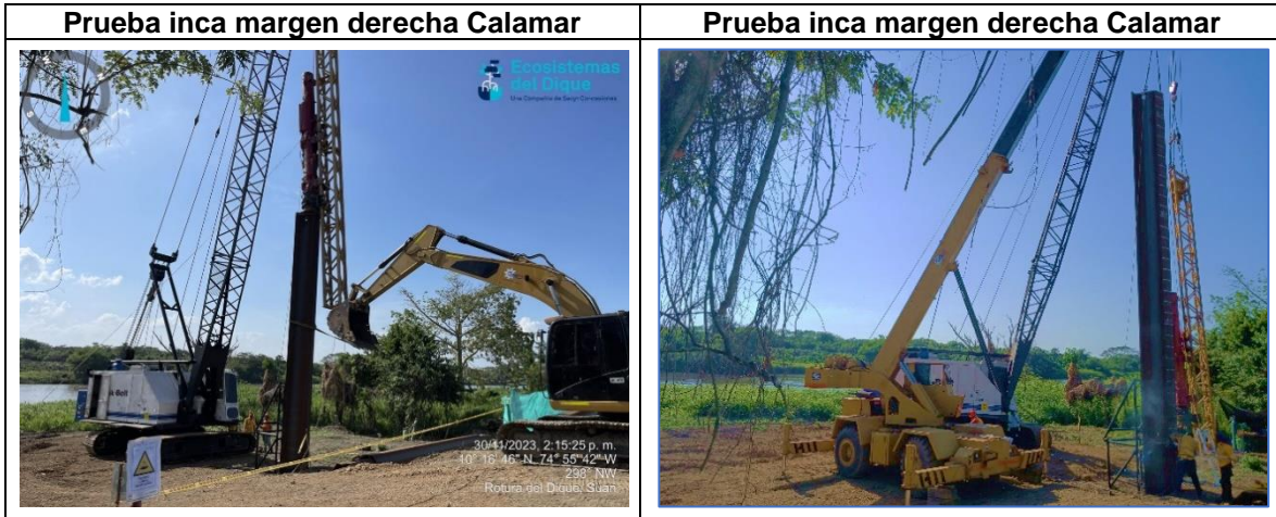
Fotografía 2. Prueba Tablestacado
