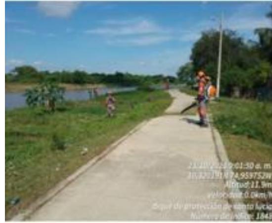
Fotografía 21. Limpieza Dique de Protección Santa Lucía UF0.
